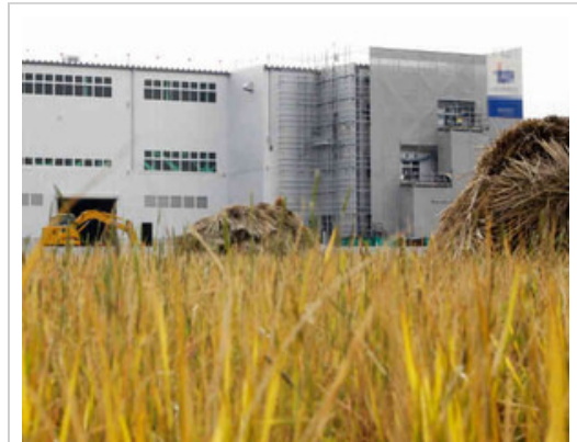
田んぼの脇で建設が進む倉庫。トヨタショックで先行きへの不安が広がる＝愛知県豊田市で
