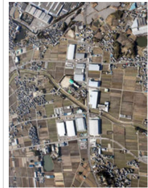
幹線道路沿いに並ぶ倉庫群＝1月、愛知県豊田市で、本社へ「まなづる」から
